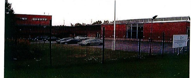
Helsingin Vanhankaupungin vedenpuhdistamo. Kuva: Yle
