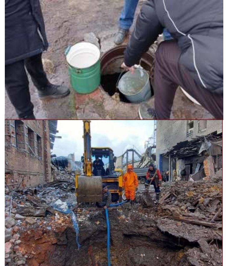
Kuva: Vodokanals of Ukraine
